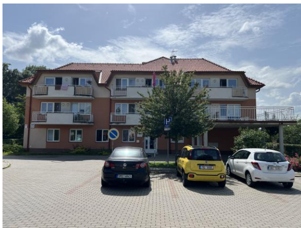
Obrázek 12: Budova objektu – Dům s pečovatelskou službou 54
