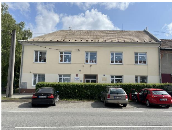
Obrázek 10: Budova objektu – ZŠ Mostkovice 243
