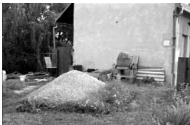
Skládka stavebního materiálu – Stichovická ul.
